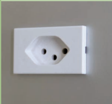
Steckdose T13-1-fach seitlich unten von aussen bedienbar
