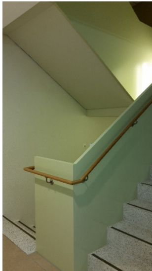
Handläufe diagonal-oval in Hartholz mit Edelstahlkonsole
