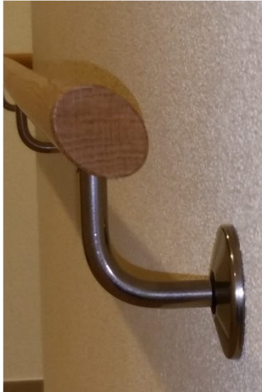
Handläufe diagonal-oval in Hartholz mit Edelstahlkonsole
