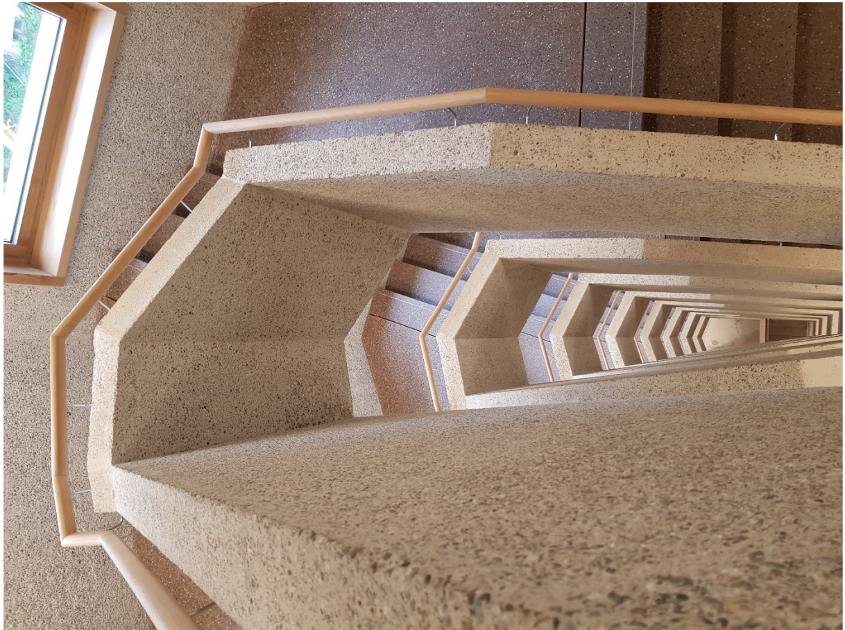
Referenzobjekt AZ Trotte Zürich – Holzhandläufe Treppenhäuser und Korridore
