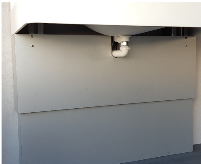
Installationsverkleidung Position hoch
